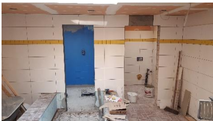
Die Damenumkleide mit den ersten Wandfliesen.
