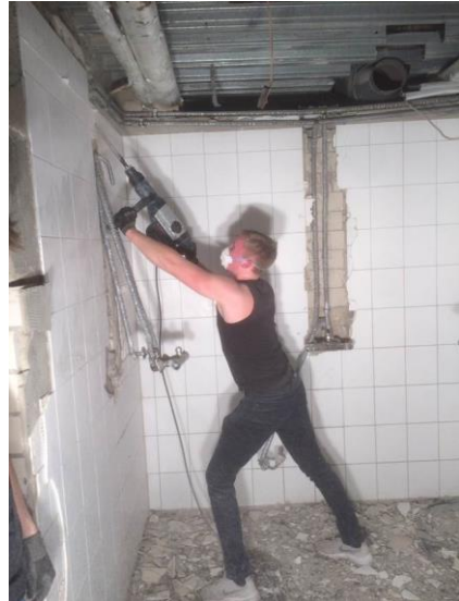
Erik Brinkmann bei der Entkernung der alten Herrendusche.
