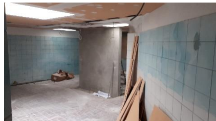
Die Herrenumkleide zwischen Sanitärinstallation und Estrichverlegung.
